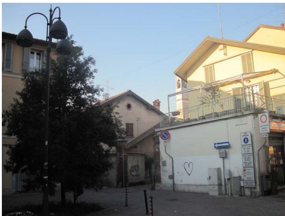
Via della Libertà: apparecchi decorativi di proprietà comunale totalmente schermati
