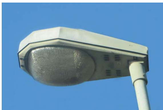
armatura stradale chiusa mediante coppa non rispondente alla L.R. 17/2000 e alla L.R. 38/2004
