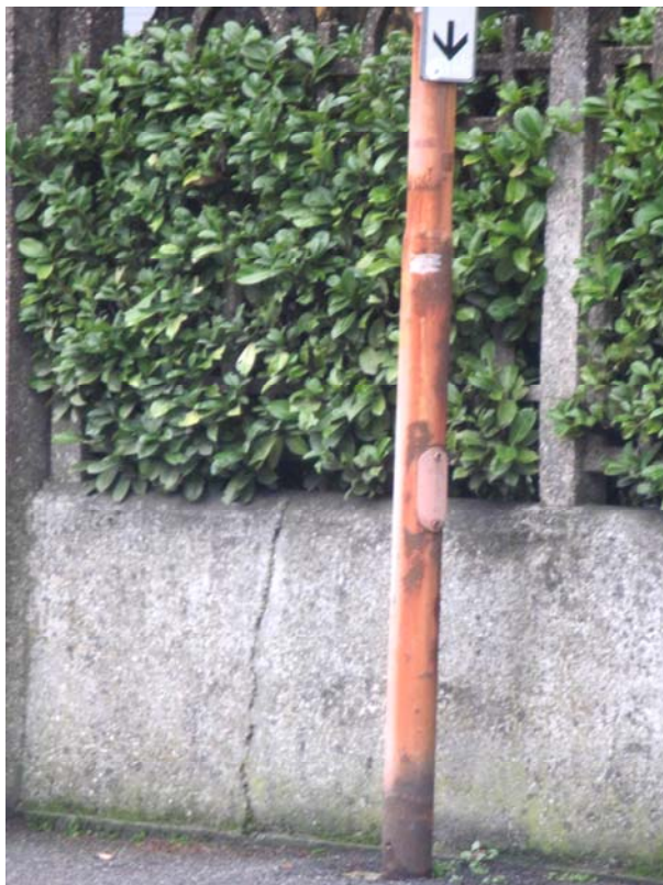
Via Alessandro Volta: sostegno vetusto e arrugginito
