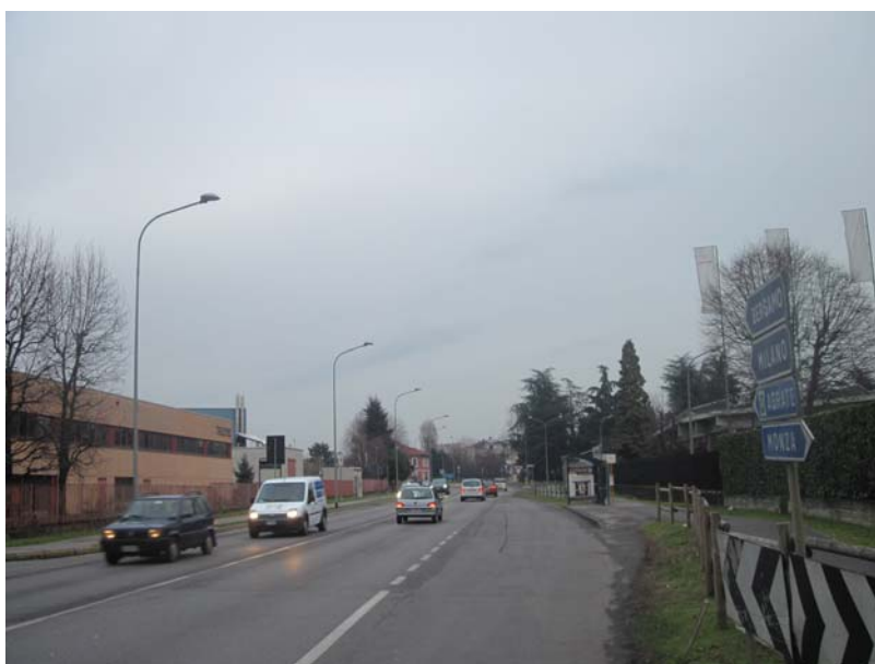
Strada Provinciale n. 2 Monza Melzo: apparecchi stradali totalmente schermati installati su palo
