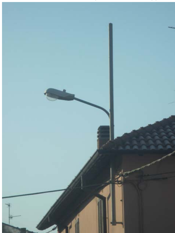
Via Massimo d'Azeglio: mensola a parete che attraversa la copertura dell'edificio
