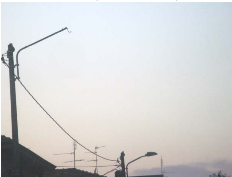
Via Ancora: giunzione di cavi su palo in c.a.c.
