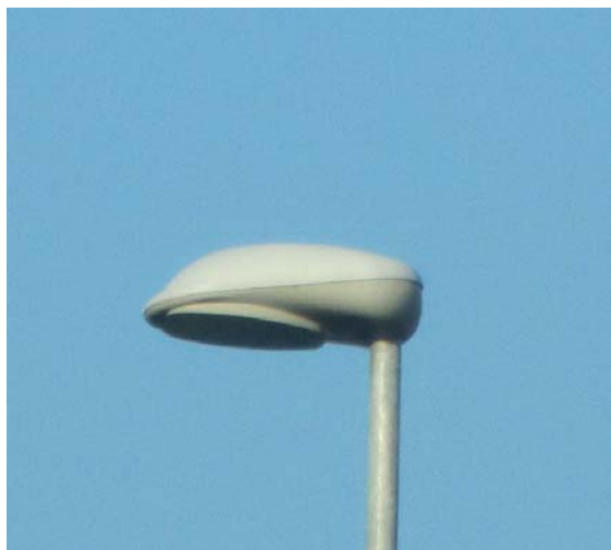
armatura stradale totalmente schermata
