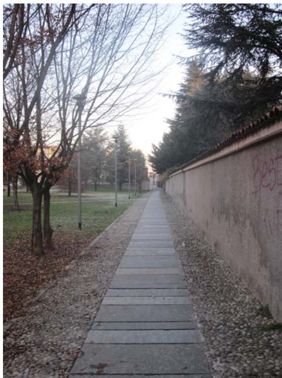
Parchetto di Via della Repubblica: impianto di illuminazione con linea interrata
